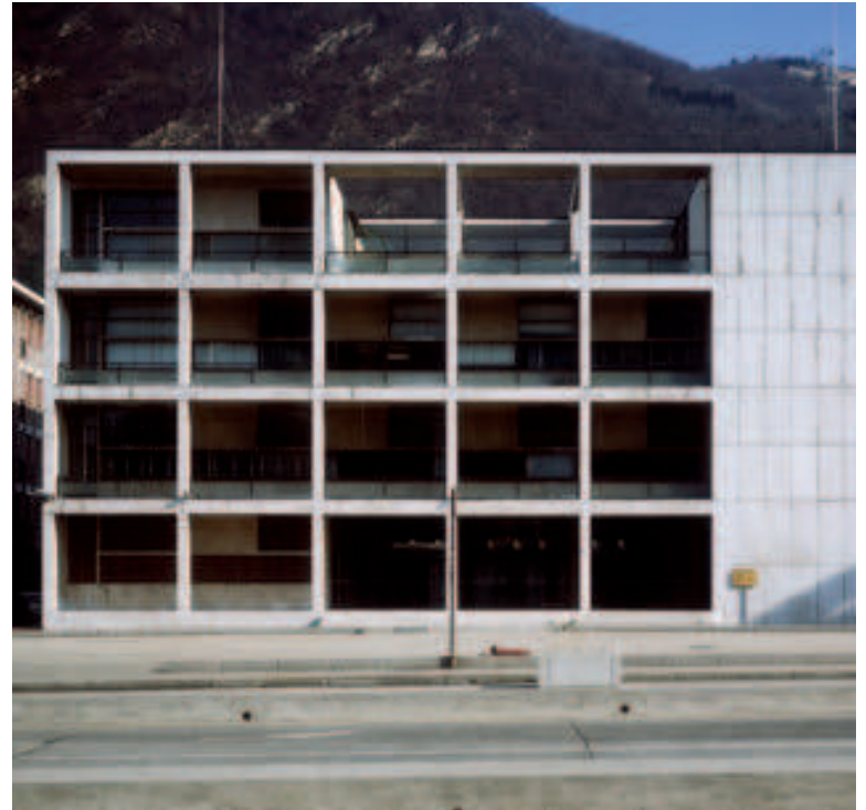
Fig. 12.23. Casa del Fascio (1936) de Giuseppe Terragni (Como, Italia). En ella se hacen evidentes los postulados del racionalismo, en especial la división geométrica de muros y fachadas.
