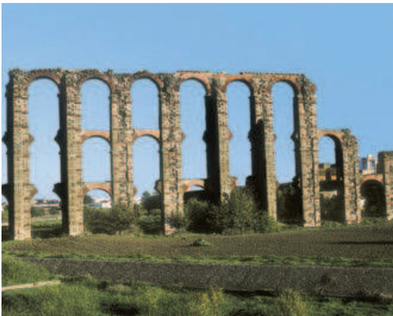
Fig. 2.24. Acueducto de los Milagros (s. I). Emplea como materiales la piedra y el ladrillo y aporta como novedad el enjarje de los arcos en los pilares, con un sistema que inspirará la sala de oración de la Mezquita de Córdoba (Mérida, Badajoz).
