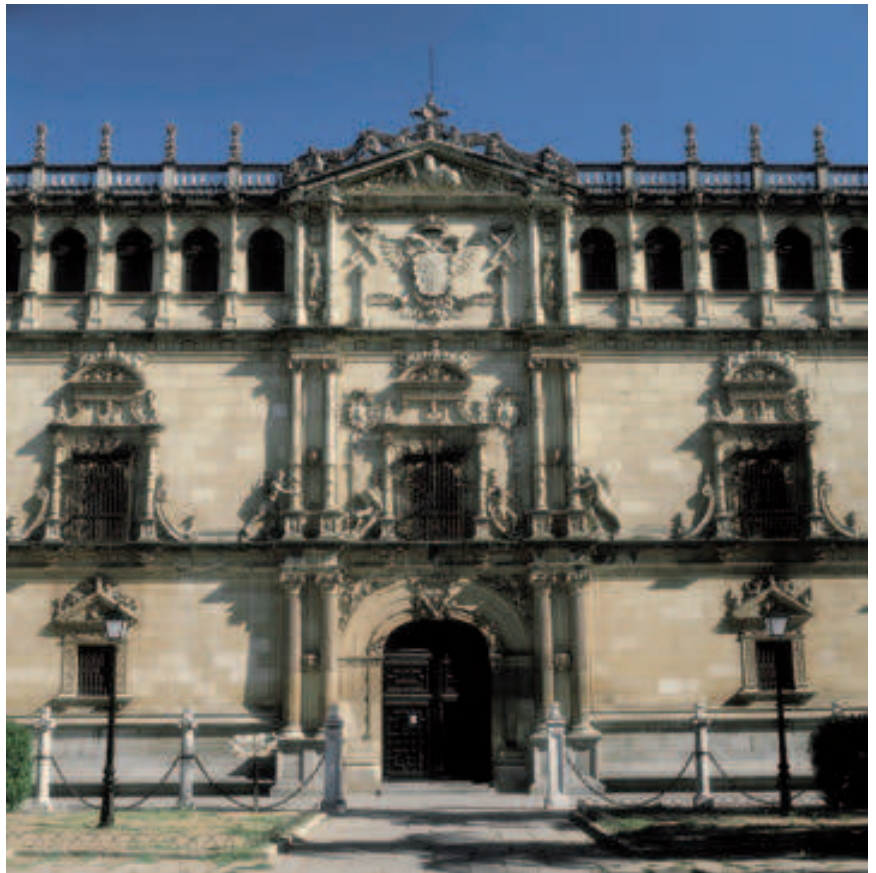
Fig. 8.10. Fachada de la Universidad de Alcalá de Henares, obra de Rodrigo Gil de Hontañón (1549). Representa el predominio de los elementos constructivos sobre los decorativos, característica del estilo purista.
