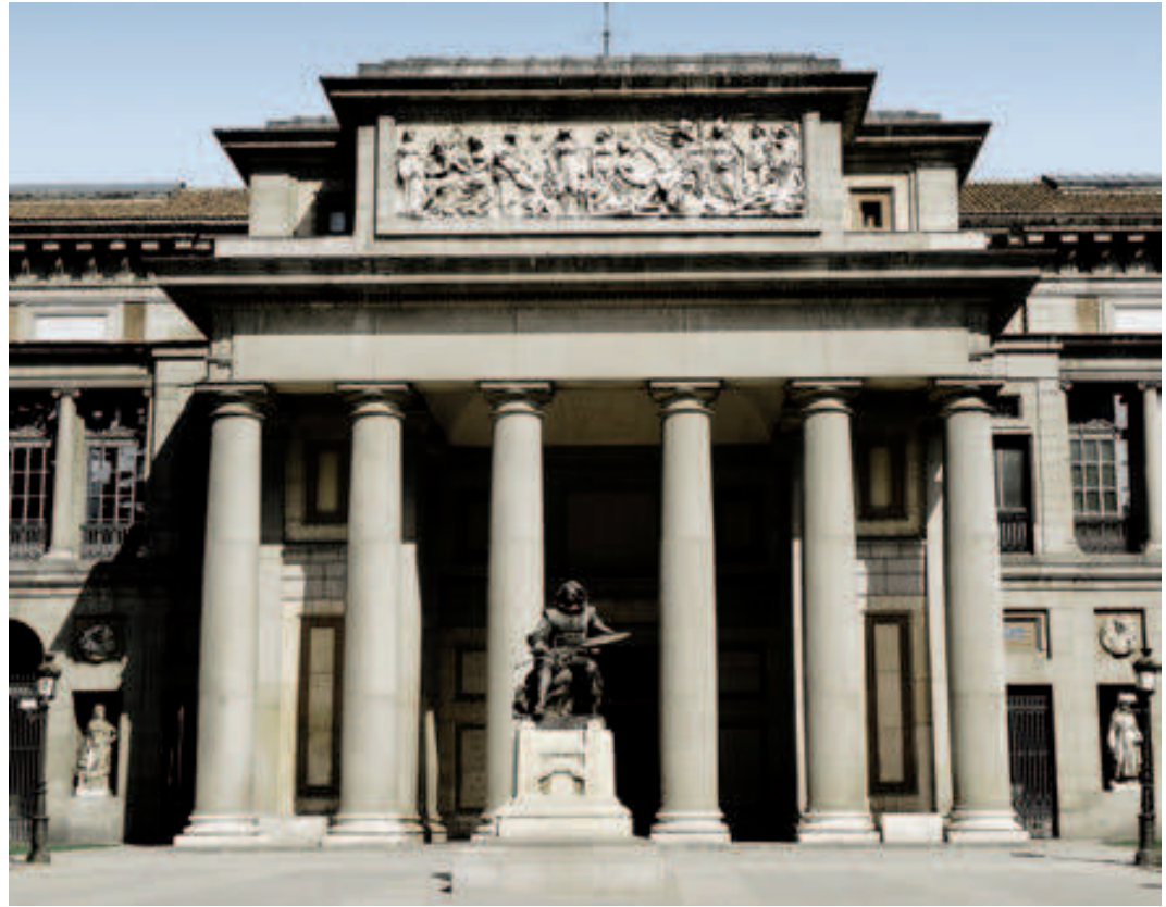
Fig. 11.14. Museo del Prado de Juan de Villanueva (1785). Concebido para ser gabinete o museo de historia natural, se convirtió en pinacoteca tras la Guerra de la Independencia. El autor utiliza varios modelos de templos clásicos para construir un edificio destinado a la diosa Razón. La llamada hoy Puerta de Velázquez es un pórtico hexástilo, dórico-toscano que cobija escultura de estética clásica. Las alas laterales están dispuestas en dos pisos, el superior con hilera de columnas jónicas y la inferior con nichos con esculturas de estética clásica (Madrid).
