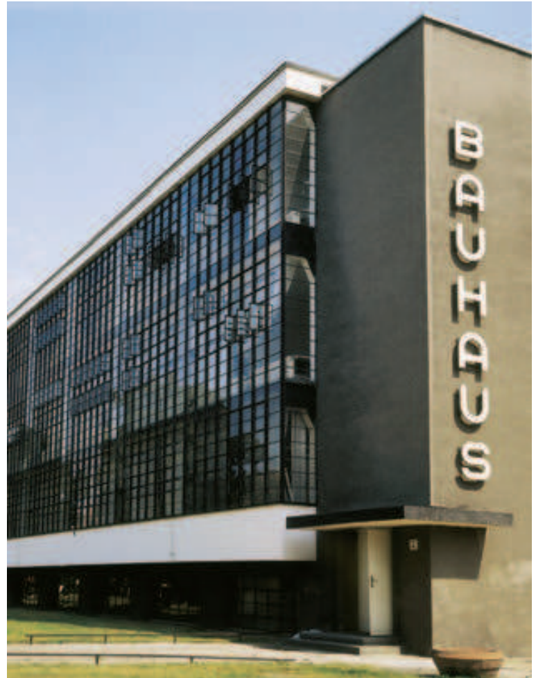
Fig. 12.20. Edificio de la Bauhaus (1925) de W. Gropius. La sede de la Bauhaus en Dessau supone quizá el mejor ejemplo del ideario arquitectónico de la escuela: su planta geométrica, aunque carente de simetría, pabellones unidos solo por los pisos superiores, formando puentes, ventanas horizontales, uso del muro cortina de cristal y la disposición ortogonal (Dessau).
