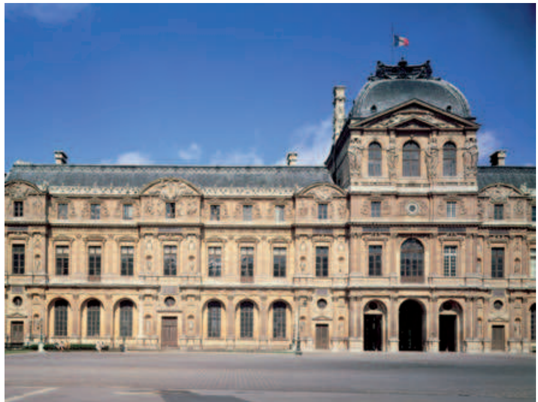
Fig. 8.1. Patio cuadrado del Palacio del Louvre de Pierre Lescot (1546). Se manifiesta la influencia del Renacimiento italiano más en el capítulo decorativo que en los aspectos estructurales.
