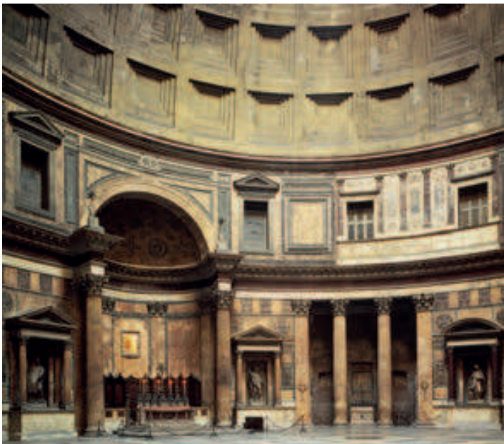
Fig. 2.21. Exterior e interior del Panteón de Roma (27 a. C.). En su exterior presenta un pronaos octástilo doble que sostiene un frontón decorado con relieves en bronce dorado (que hoy se encuentran en la Basílica de San Pedro del Vaticano). En el interior una gran cúpula de media naranja construida con materiales ligeros domina todo el espacio y se apoya sobre un tambor. Una sucesión de arcos se van enlazando de forma concéntrica hasta llegar
