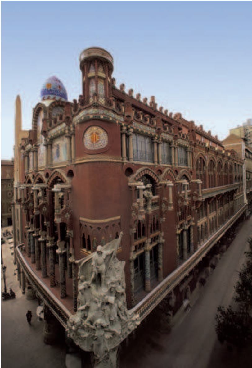
Fig. 12.10. Palacio de la Música de Barcelona de Doménech i Montaner. Se conjugan los elementos del gótico catalán y las aportaciones del modernismo.
