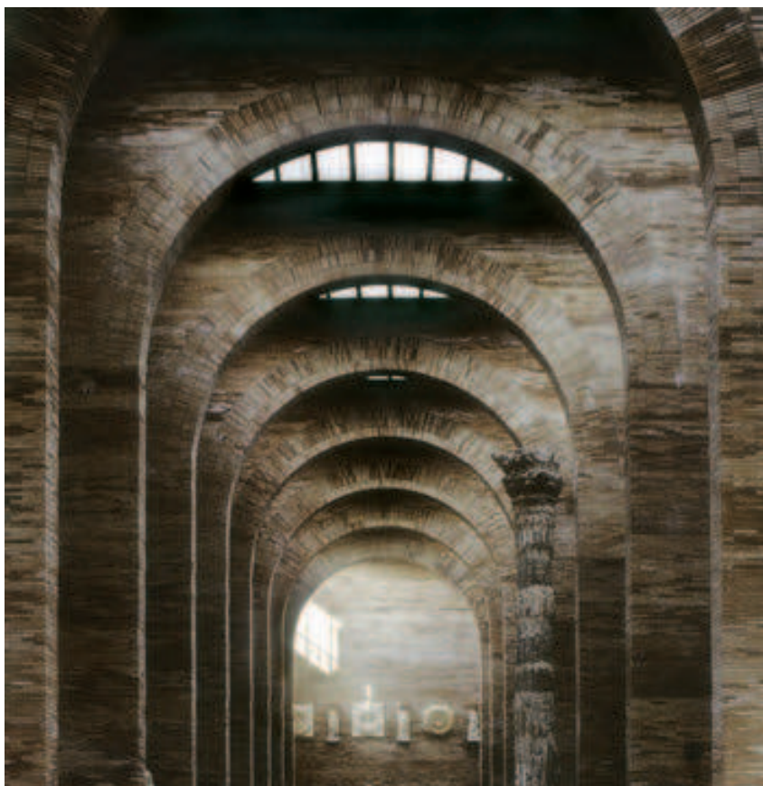
Fig. 12.26. Museo de Arte Romano de Mérida. (1980-1985) de Moneo. Excepcional ejemplo de arquitectura adaptada a su función sin renunciar al lenguaje de los nuevos materiales. Moneo establece una perfecta relación entre los colores del ladrillo y los objetos de mármol allí expuestos. Las bandas de cristal en el techo y las altas ventanas laterales proporcionan una iluminación natural.
