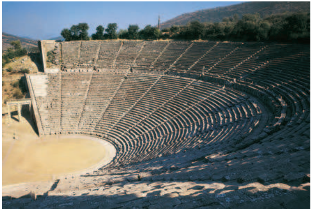
Fig. 2.9. Teatro de Epidauro (siglo IV). Se utilizó un desnivel natural del terreno de 24 metros para edificar una concha de 120 metros de diámetro que se divide en dos zonas. En total podía albergar hasta 15 000 espectadores.
