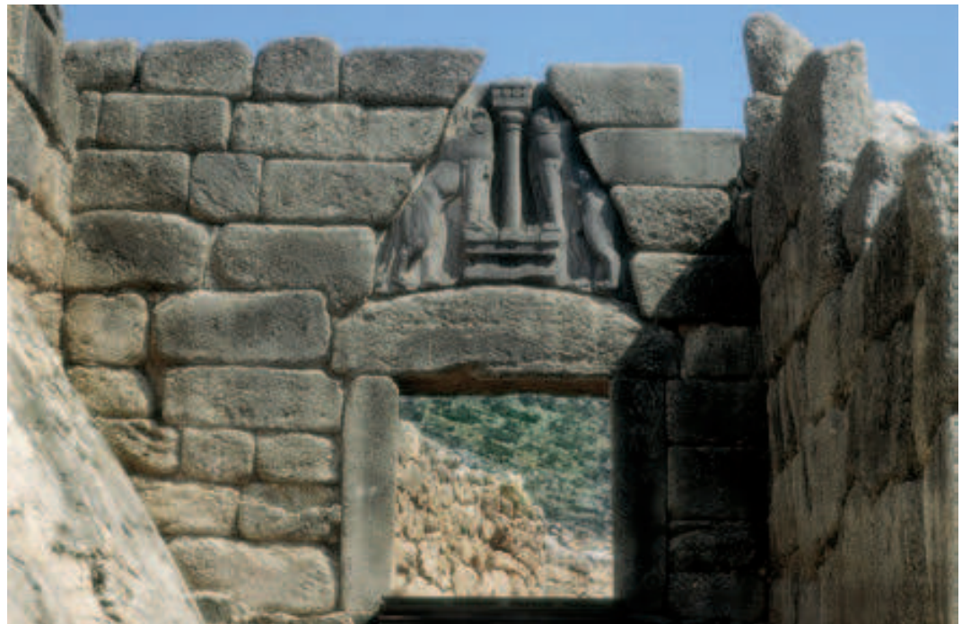
Fig. 2.4. Puerta de los Leones (inicios del I milenio a. C.). Principal ejemplo de construcción ciclópea con una decoración escultórica compuesta por dos leones afrontados que revela la influencia del arte mesopotámico (Micenas, Grecia).
