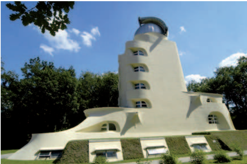
Fig. 12.18. Torre Einstein (1919-1921) de Mendelsohn. Esta obra se basa en el manejo de la forma y los materiales como si fuesen blandos y maleables, mostrándonos la capacidad dúctil de los distintos materiales constructivos, sobresaliendo el hormigón (Postdam).
