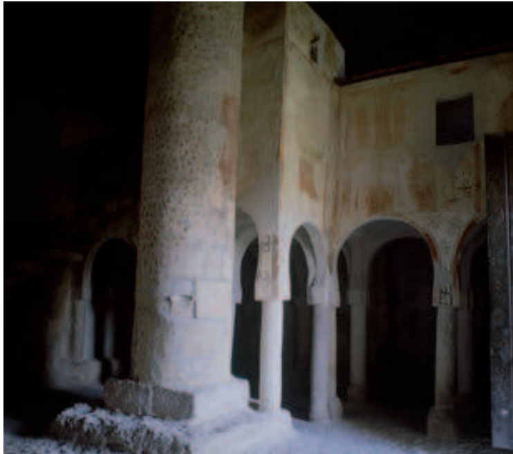
Fig. 3.18. Interior de la Iglesia de San Baudelio de Berlanga (Soria, siglo x). Con el gran soporte central en forma de palmera que se convierte en el elemento protagonista del espacio interior.
