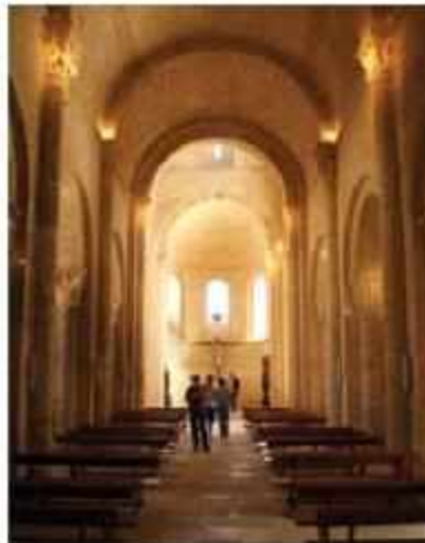
Bóveda acañonada de piedra de la iglesia de San Martín de Frómista, en Palencia.
