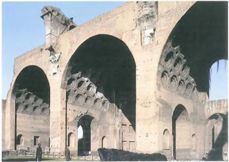
Basílica de Majencio o de Constantino (s. IV d.C.). Es de proporciones colosales y aún conserva el arranque de los arcos que sostenían las tres bóvedas de la nave central.
