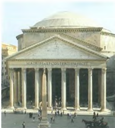
Panteón de Agripa (s.II d.C.). Magnífico templo de planta circular cuyos muros sostienen una gigantesca bóveda.
