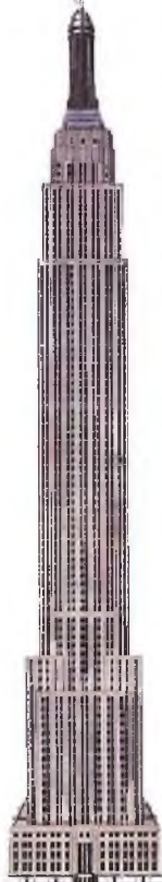
Mirador en el piso 102
