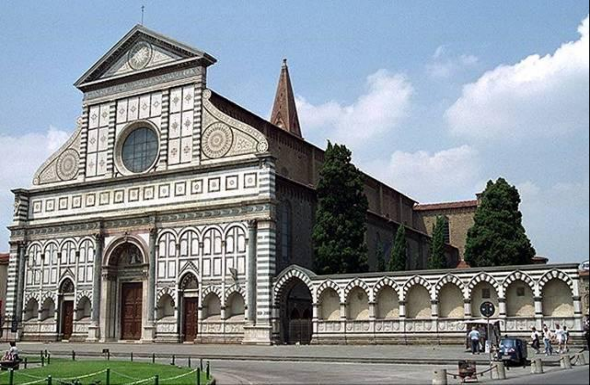
Santa María Novella , Florencia. Remodelación de la fachada: 1456
