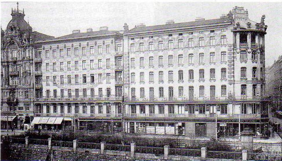
468. Otto Wagner, edificios de viviendas en Linke Wienzeile 38-40, Viena (1898-1899). El de la izquierda se conoce como la "Casa Mayólica" por el material cerámico del gran motivo ornamental que abarca toda la fachada.
