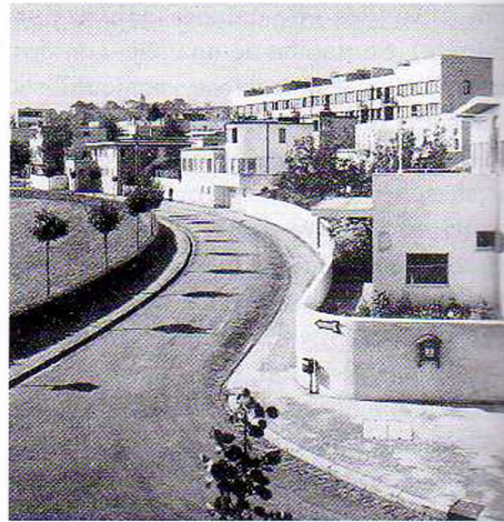
513. Colonia Weissenhof, Stuttgart (1927). Éste fue el primer conjunto internacional de edificios realizados según las pautas de la nueva arquitectura moderna. Mies se encargó del trazado general y construyó el bloque longitudinal que corona el conjunto.
