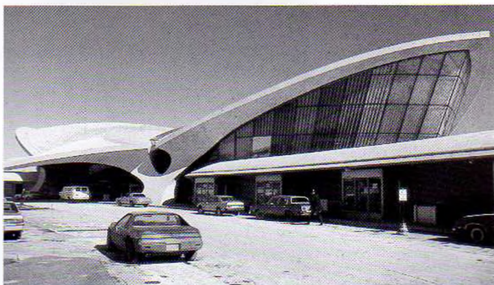
540. Eero Saarinen, Terminal TWA, Aeropuerto Kennedy, Nueva York (1956-1962). Cuatro enormes casquetes de hormigón apoyan en grandes patas, formando una especie de pájaro gigantesco con las alas extendidas para emprender el vuelo.
