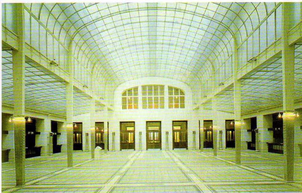
480. Otto Wagner, Caja Postal de Ahorros, Viena (1904-1906). El espacio interior de la sala de operaciones presenta tres naves cubiertas por bóvedas de vidrio, continuas, ligeras y traslúcidas, que dejan pasar una luz matizada y difusa.
