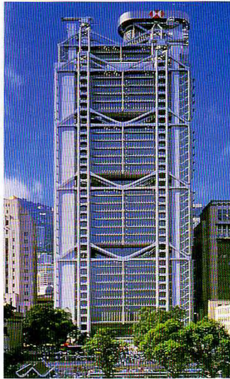
564. Norman Foster. Banco de Hong Kong y Shanghai. Hong Kong (1979-1985). En un gran alarde tecnológico, la estructura exhibe al exterior sus colosales soportes y sus grandes ménsulas invertidas, de las que cuelgan conjuntos de varias plantas.
