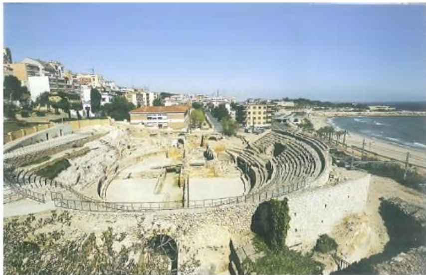
El anfiteatro romano de Tarragona (s. II d.C.) presenta una parte de la cavea excavada en la roca y la otra construida sobre bóvedas inclinadas en opus caementicium .
