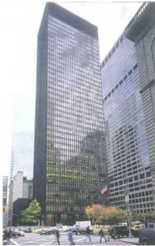
MIES VAN DER ROHE : Seagram building (1954-1958). Situado en el corazón de Manhattan (Nueva York) la enorme pesadez de este rascacielos es solucionado por el arquitecto situando unos potentes pilotes en la planta baja, que permiten elevar todo el bloque del suelo y producen una contradictoria sensación de ligereza.
