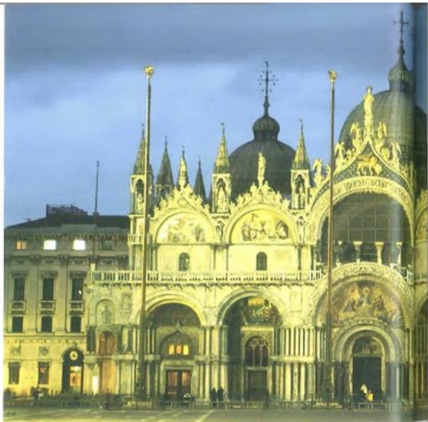
San Marcos de Venecia (Siglo XII). De planta de cruz griega, cubierta por cinco cúpulas, se le añadió (Siglo XIII) un nártex de pequeñas cúpulas en torno al brazo de los pies.
