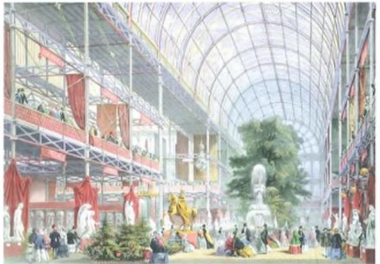
Litografía coloreada del Palacio de Cristal de Joseph Paxton (1851). Este edificio está considerado el paradigma de la arquitectura del hierro y el vidrio.
