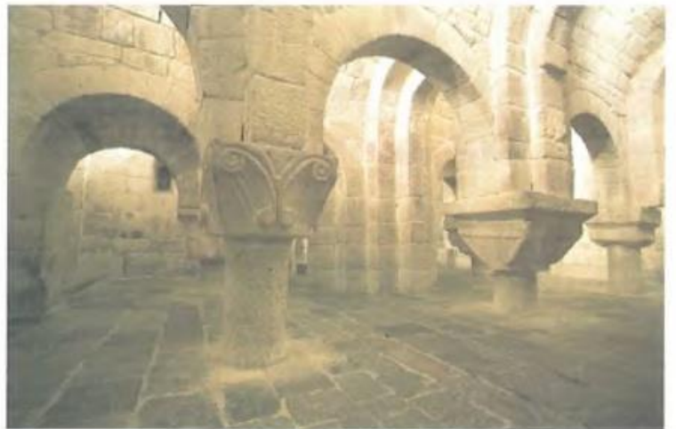
Monasterio de San Salvador de Leyre (1057), Navarra. La cripta, construida para nivelar el suelo de la iglesia, dispone de cuatro naves con bóvedas de cañón y tres ábsides.
