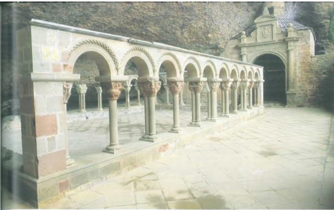
Monasterio de San Juan de la Peña (ss. XI-XII), Huesca. De remoto origen visigodo y mozárabe, lo mejor del monasterio pertenece a la época del románico. Destaca sobre todo su espectacular claustro, construido al aire libre, pero bajo el abrigo de la gran peña que cubre todo el recinto del monasterio.
