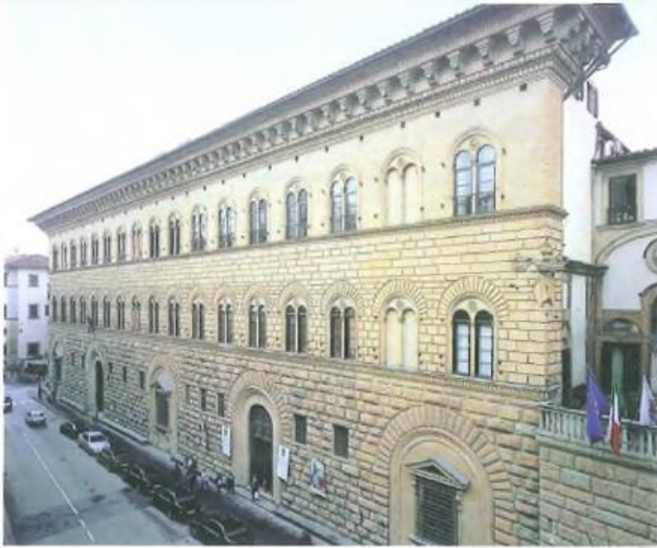
MICHELOZZO: Palazzo Medici-Riccardi (1464), Florencia. Mantiene la esencia de palacio renacentista creada por Brunelleschi en el Palazzo Pitti, pero marca mucho más la diferencia entre el almohadillado de las dos plantas y adorna las ventanas con parteluces.
