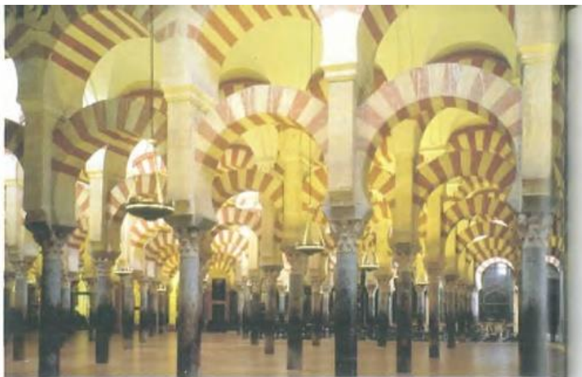
Interior de la sala de oración (haram) de la mezquita de Córdoba (785-987). El uso de dovelas bicolor (rojas y blancas) confiere al conjunto un efecto decorativo muy original.
