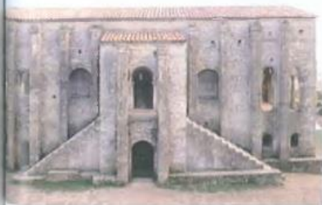
Vista de la fachada norte.
