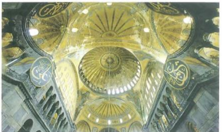
Bóvedas de Santa Sofía, Constantinopla (Siglo VI). La cúpula descansa sobre dos medias cúpulas, cuatro grandes arcos y cuatro pechinas, recubierto todo de mosaicos.
