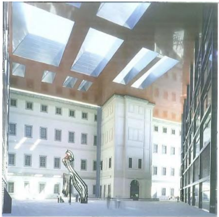
JEAN NOUVEL: Ampliación del Centro de Arte Reina Sofía de Madrid (2001- 2005). Gracias a las diversas aperturas cenitales, el arquitecto consigue mantener la iluminación interior en un nivel prácticamente constante.
