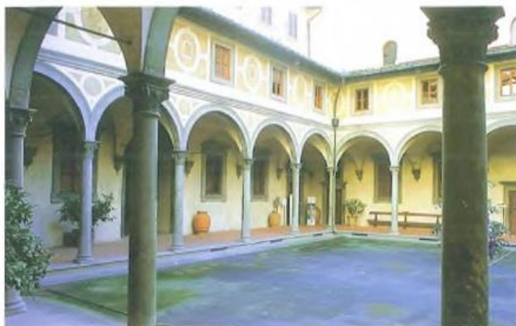
FILIPPO BRUNELLESCHI: Hospital de los Inocentes (1419-1427). El orden geométrico preside esta galería de arcos de medio punto sobre columnas con capitel corintio.
