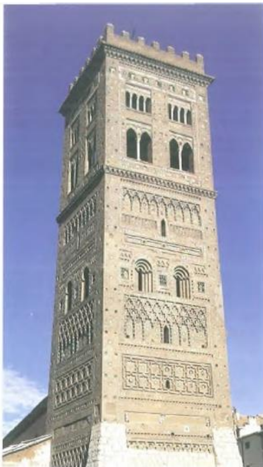
Torre campanario de la iglesia gótico-mudéjar de San Martín de Teruel (s. XIV). La decoración es de cerámica vidriada, de planta cuadrada independiente de la iglesia. En la parte inferior hay una serie de adornos llamados paños de sebka, retícula de rombos difundidos por los almohades.
