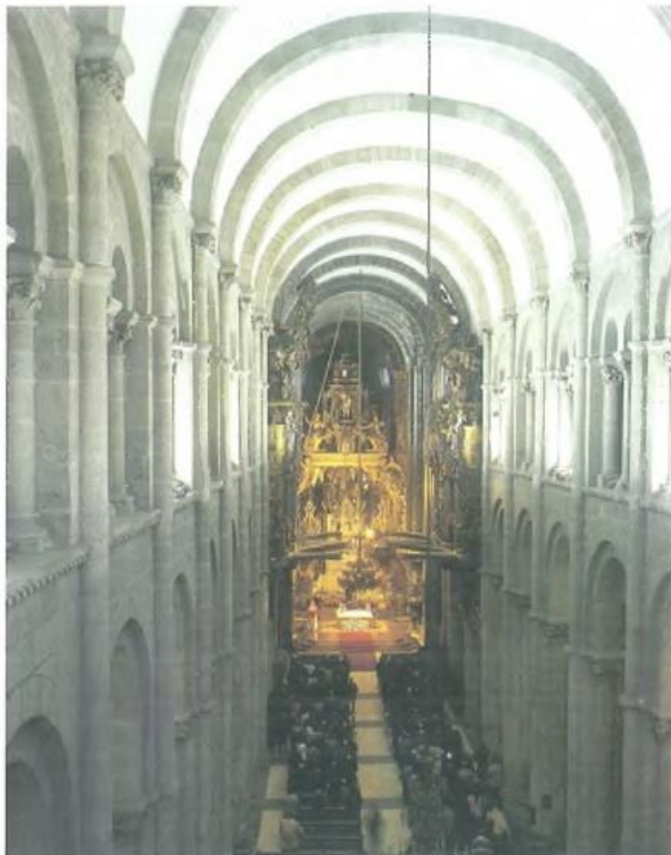
Catedral de Santiago de Compostela (1075-1130). De grandes proporciones, como correspondía a una de las tres metas de peregrinación, es de planta de cruz latina, de tres naves, incluso en el largo crucero. Las laterales y la galería superior se continúan en la girola. La nave central tiene bóveda de cañón y las laterales, bóvedas de arista.
