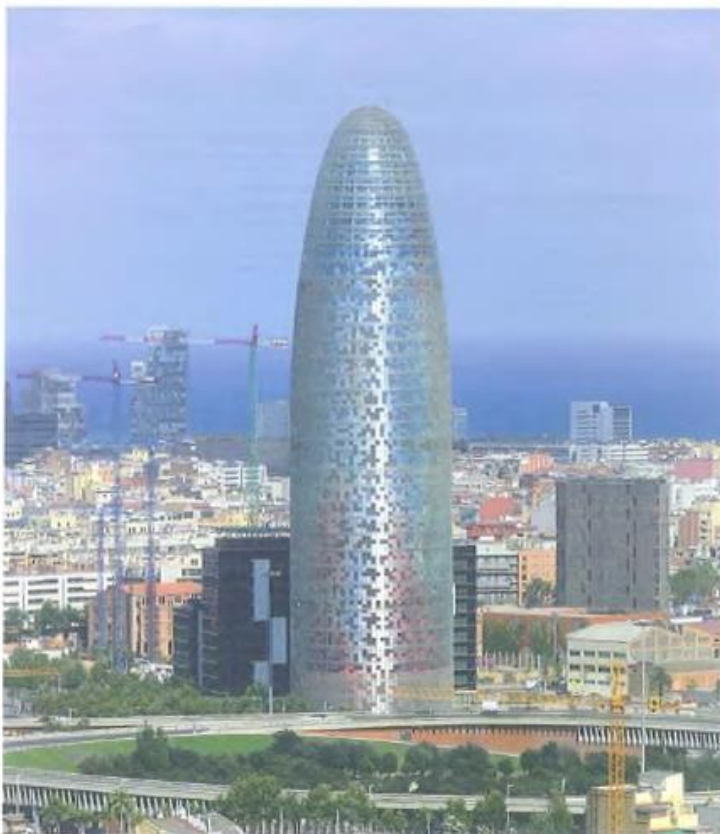
JEAN NOUVEL: Torre Agbar de Barcelona (1999-2005). Las 4500 ventanas que conforman la fachada uniforme de este edificio están concebidas para conseguir una ventilación natural, aprovechar al máximo la luz solar, reducir el gasto energético e intentar generar un baño uniforme de luz en el interior.
