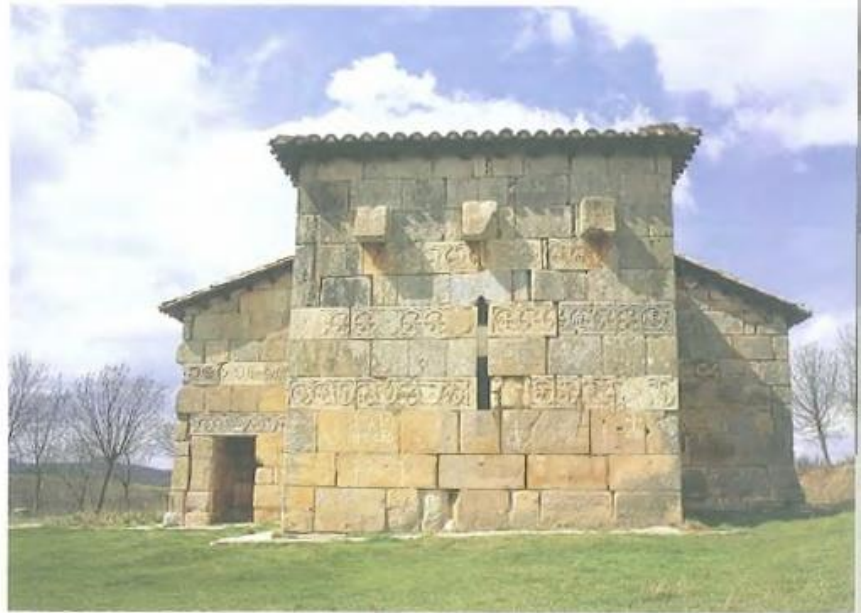
Iglesia de Quintanilla de las Viñas (s. VII), Burgos. Sólo se conserva la cabecera, pero posee una rica decoración en relieves planos y a bisel en el arco, en las impostas y en fajas horizontales del muro exterior.
