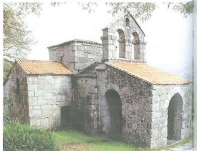
Santa Comba de Bande (s. VII), Orense. Presenta planta de cruz griega alargada en cabecera y pies y se cubre con bóveda de arista.
