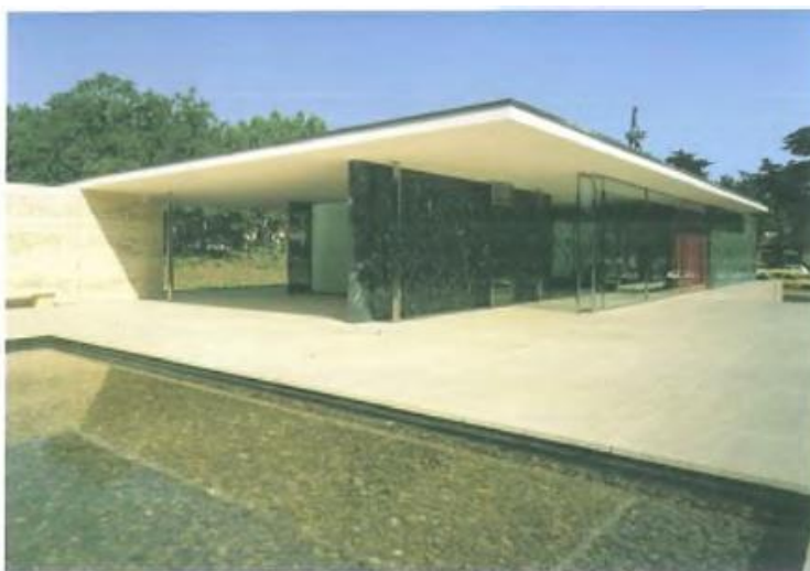
MIES VAN DER ROHE : Pabellón alemán (1929). El arquitecto alemán utilizó una estructura de esbeltos pilares de acero cromado que le posibilitaron sustituir las paredes y crear una planta libre y diáfana.
