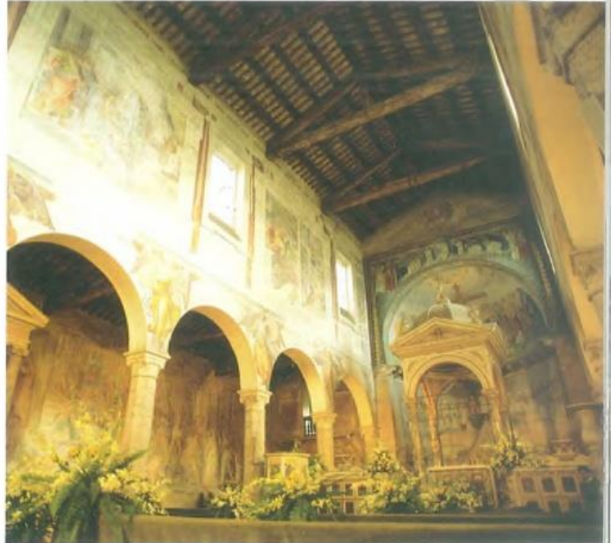
Interior de la Basílica paleocristiana de San Nereo y Achilleo, Roma (s. IV). En la imagen se aprecia la cubierta de madera a dos aguas que substituye la tradicional bóveda de cañón romana.
