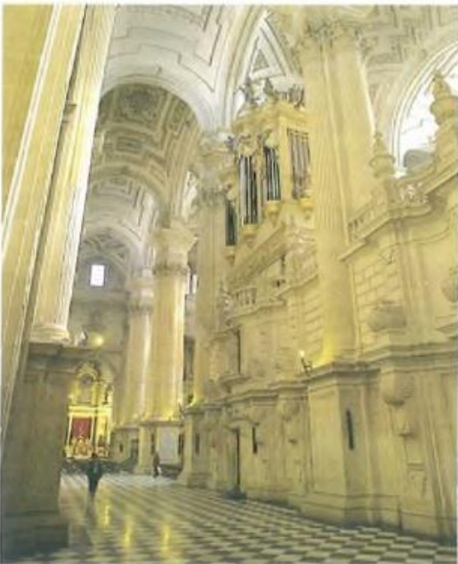
ANDRÉS DE VANDELVIRA: Catedral de Jaén (1540). Tiene planta de salón (naves de igual altura) y bóvedas valdas. Sus pilares, muy altos, se inspiran en los de la Catedral de Granada.
