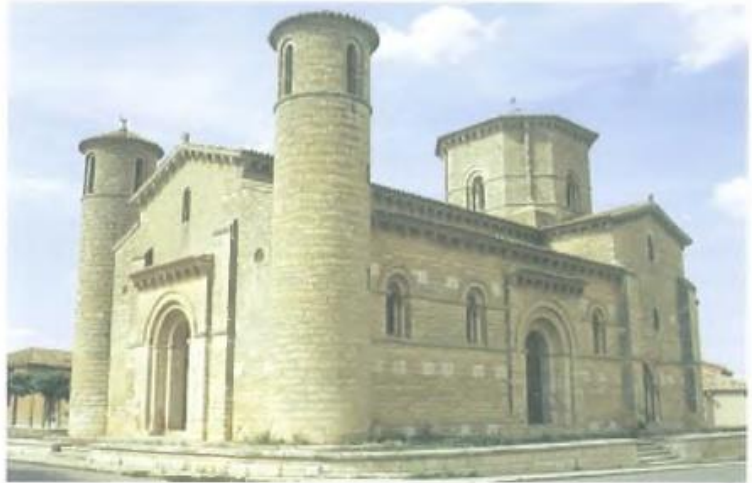
San Martín de Frómista (1066), Palencia. De tres naves con sendos ábsides en la cabecera, tiene planta basilical pero con transepto que no sobrepasa el rectángulo. Consta de cimborrio octogonal en el crucero y dos torres campanario a los pies. Las naves, de escasa altura, se cubren con bóveda de cañón. Se halla en el Camino de Santiago.
