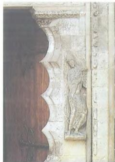
Detalle del parteluz de la entrada.
